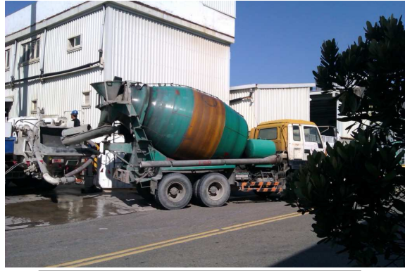
3000 磅預拌混凝土
