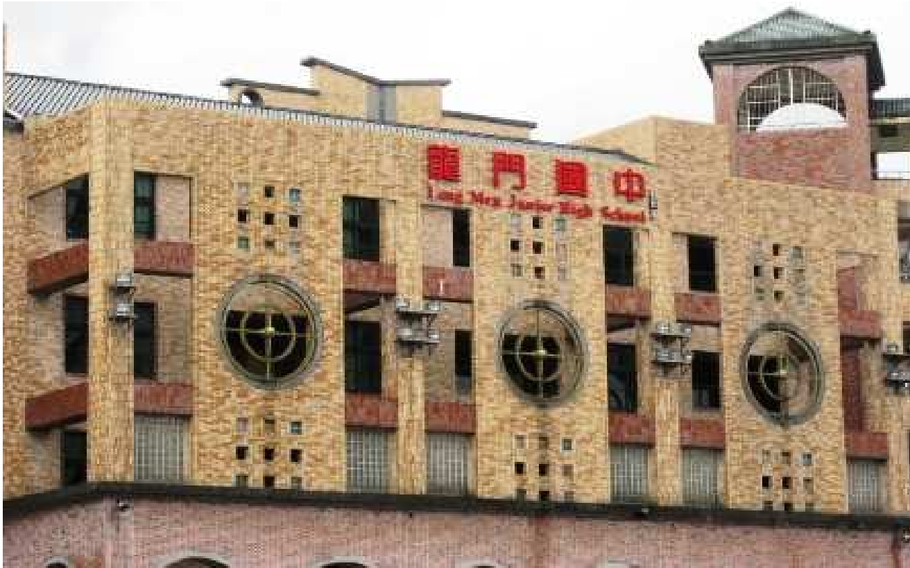
台北龍門國中安裝 HSL-02 太陽能路燈安裝實例 102 年 9 月
